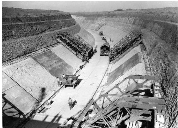
Figure 23 : La construction du canal Philippe Lamour, qui a permis l'irrigation du Languedoc Roussillon avec l'eau du Rhône à partir de 1960 (Photo : Pervenchon, groupe BRL)
